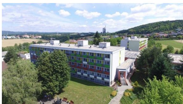
Obr. č. 1: Pohled na pavilon 1
