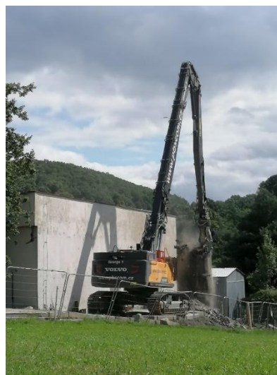
Obr. č. 51: Demolice komína
